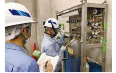
排ガス処理筒交換実技指導
