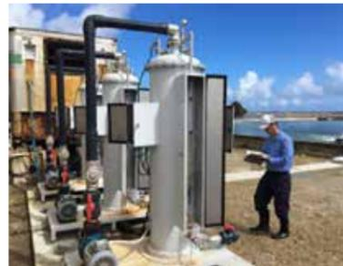
養殖場に設置された、高濃度酸素溶解装置
