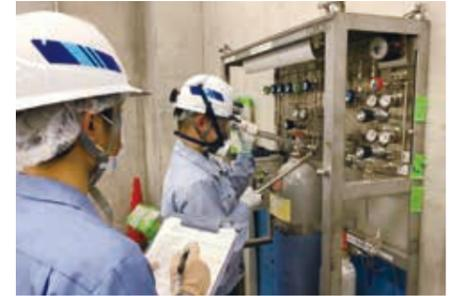
排ガス処理筒交換実技指導
