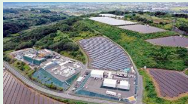
グリーン水素出荷拠点（山梨県米倉山）
