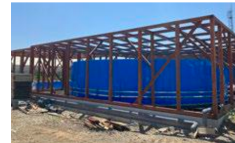
建設中の養殖水槽
