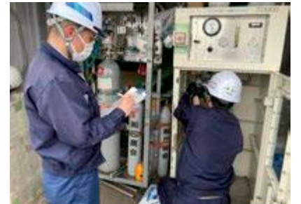
排ガス処理筒交換実技指導
