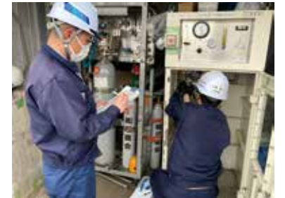
排ガス処理筒交換の実技指導
