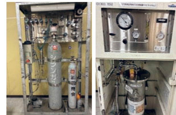
排ガス処理筒交換の実技指導で使用される実機モデル
